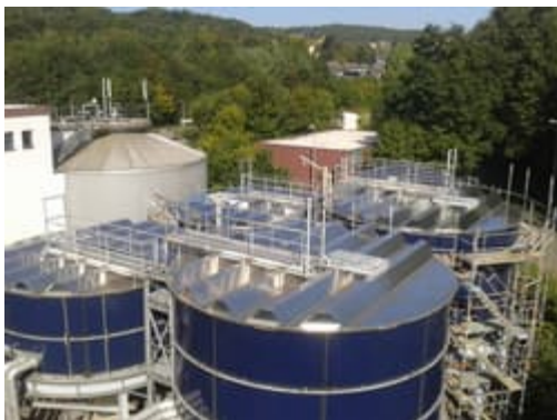
KA Schwelm (Wupperverband): 5 St. Alu-Abdeckungen je \varnothing 7,8 m für Eindickergruppe.
