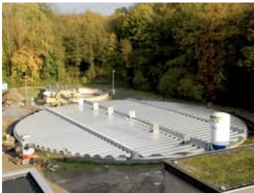
KA Solingen Gräfrath: Alu- Abdeckung auf Rohabwasser- speicherbecken \varnothing 42m.
