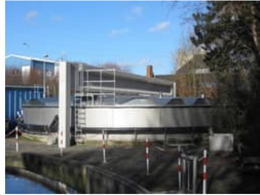
KA Rösrath: Alu-Abdeckung auf Zentralwasserspeicher mit Stahlbetonportalkonstruktion.
