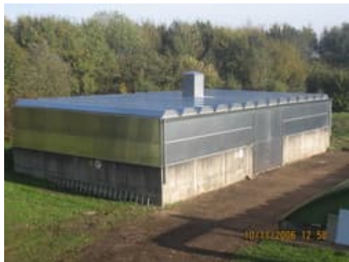
KA Rösrath: Alu-Abdeckung auf Zentralwasserspeicher mit Stahlbetonportalkonstruktion.
